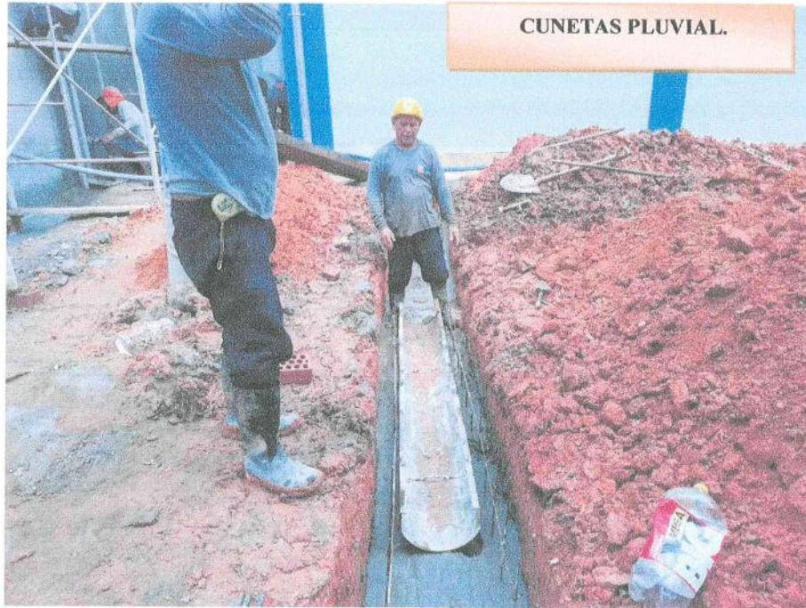
Fotografía N° 09: Vista fotográfica donde se aprecia el trabajo de vaciado de cunetas pluviales en inicial.
