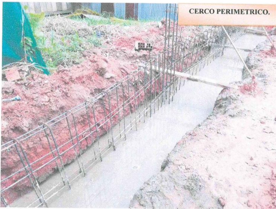
Fotografía N° 04: Vista fotográfica donde se aprecia el trabajo de vaciado de cemento corrido en cerco perimetrico.
