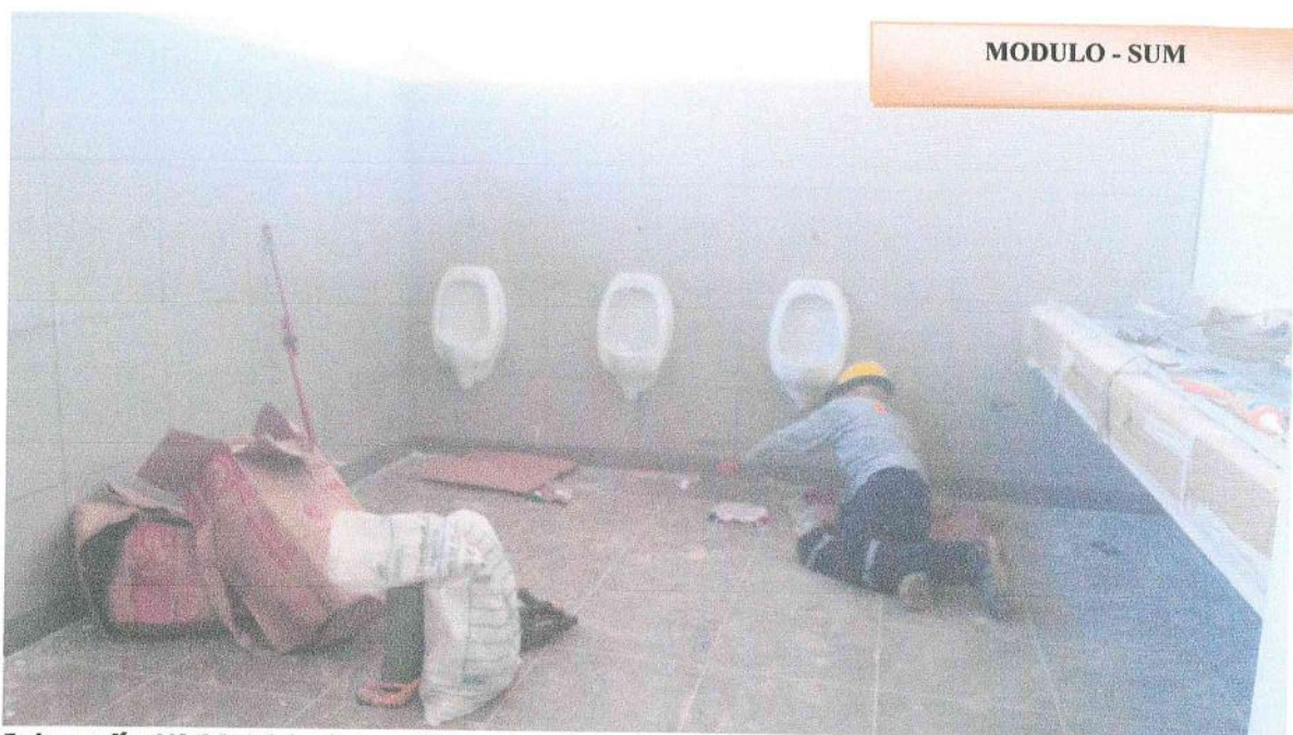
Fotografía N° 12: Vista fotográfica donde se aprecia el trabajo de instalación de urinarios, lavatorios en ss.hh – sum.
