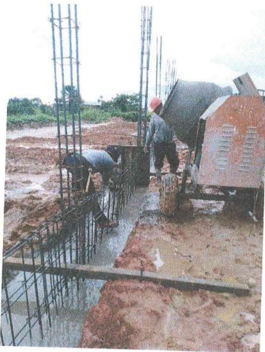
FOTO N° 13. VACEO DE CIMIENTO EN CERCO PERIMETRICO.
