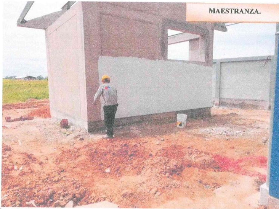
Fotografía N° 07: Vista fotográfica donde se aprecia el trabajo de pasta mural en maestranza.
