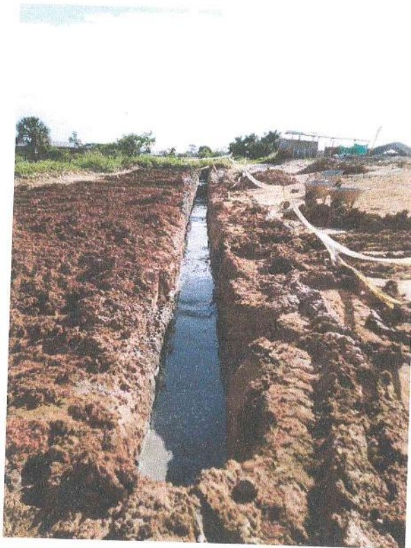
FOTO N° 12. VACEADO DE CONCRETO EN SOLADO PARA CERCO PERIMETRICO.
