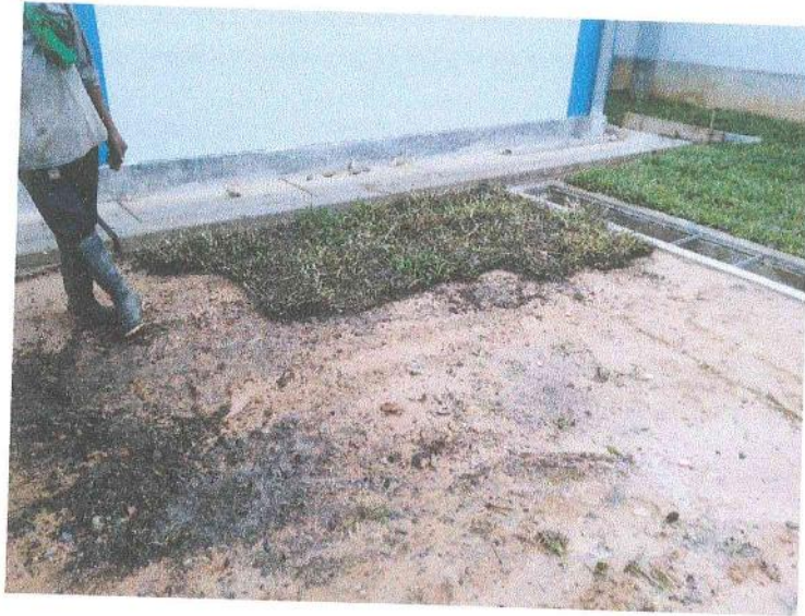
FOTO N°03. COLOCACIÓN DE GRASS EN AREAS LIBRES.
