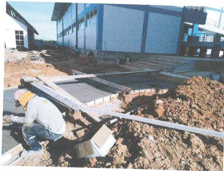
FOTO N° 05. ENCOFRADO Y VACIADO DE CONCRETO EN VEREDAS DE LA PERGOLA DE CIRCULACION.
