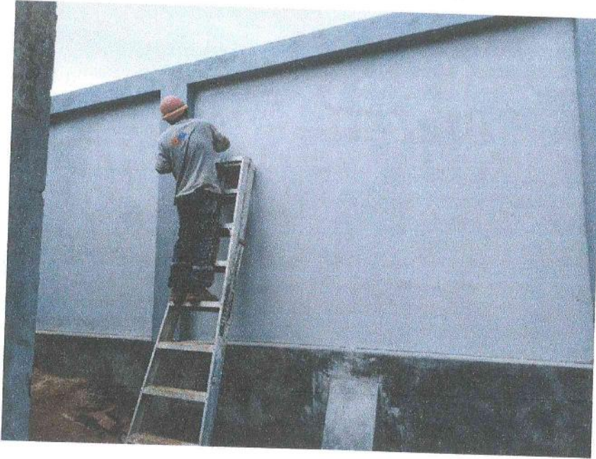
FOTO N° 08. APLICACIÓN DE PINTURA PRIMERA MANO EN CERCO PERIMETRICO COLINDANTE AL AA. HH MALECON SHANUSI.
