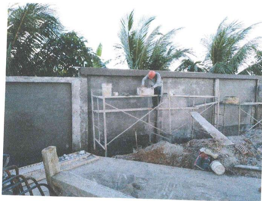
FOTO N° 11. TARRAJEO DE VIGAS DE CERCO PERIMETRICO COLINDANTE AL AA. HH MALECON SHANUSI.
