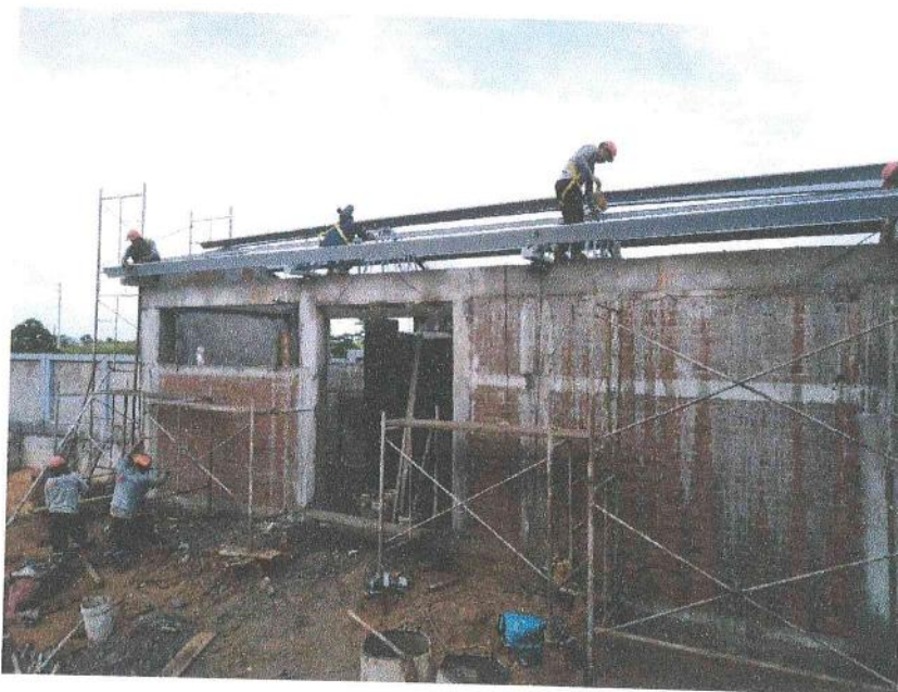
FOTO N° 14. ASENTADO DE LADRILLOS EN CASETA DE SUB ESTACIÓN ELÉCTRICA Y CÁMARA DE BOMBEO.
