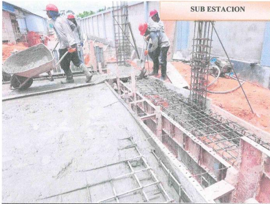
Fotografía N° 01: Vista fotográfica donde se aprecia el trabajo de vaciado de losa de cimentación en subestación.
