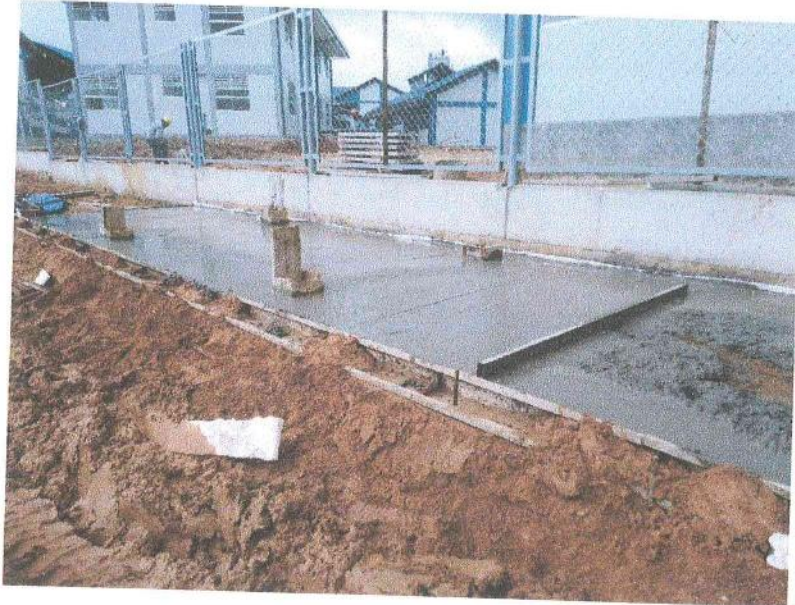
FOTO N° 05. ENCOFRADO Y VACIADO DE CONCRETO EN VEREDAS DE LA PERGOLA DE CIRCULACION.
