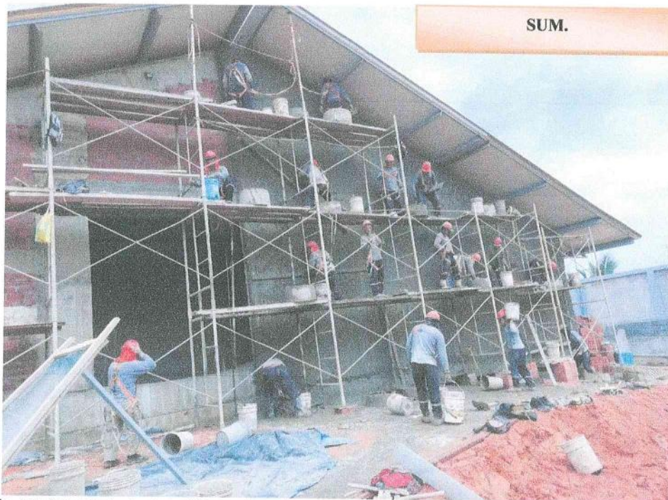
Fotografía N° 06: Vista fotográfica donde se aprecia el trabajo de tarrajeo de fachada en Sum.
