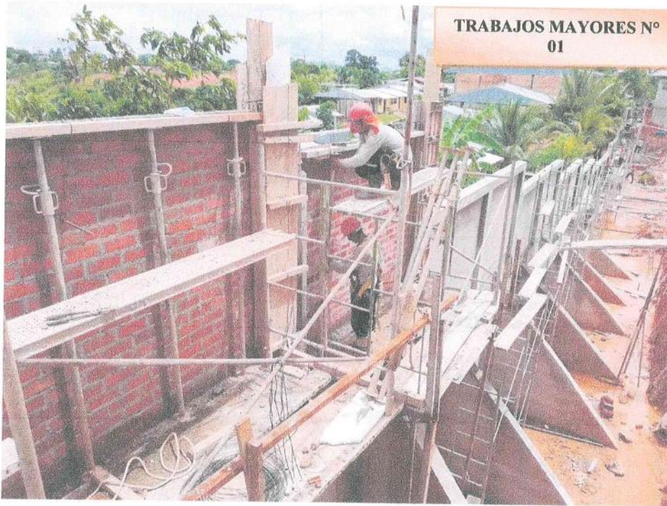
Fotografía N° 05: Vista fotográfica donde se aprecia el trabajo de encofrado de vigas en muro de contención.
