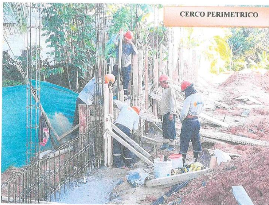
Fotografía N° 11: Vista fotográfica donde se aprecia el trabajo de encofrado de sobrecimiento en cerco perimetrico.
