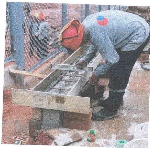
FOTO N°02. ENCOFRADO PARA JARDINERIA TIPO BANCA.
