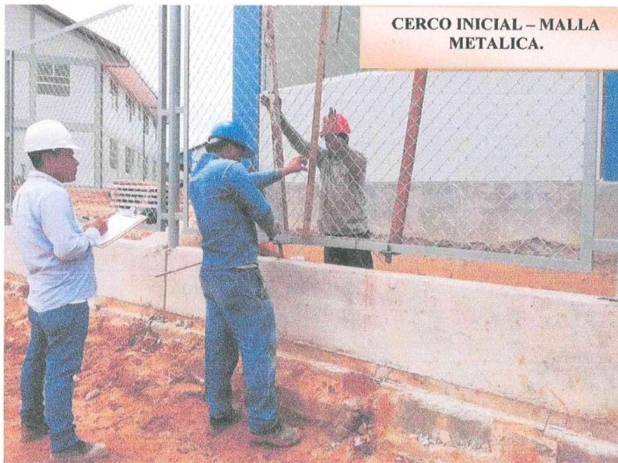
Fotografía N° 02: Vista fotográfica donde se aprecia el trabajo de colocación de malla metálica en cerco – inicial.
